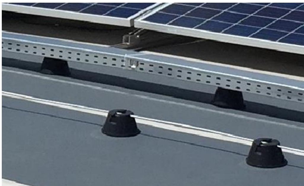
Slika 7. Detalj postavljanja kanalice
